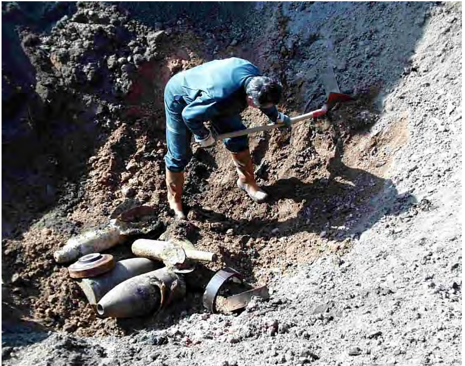
Préparation d'une destruction en fourneau.
